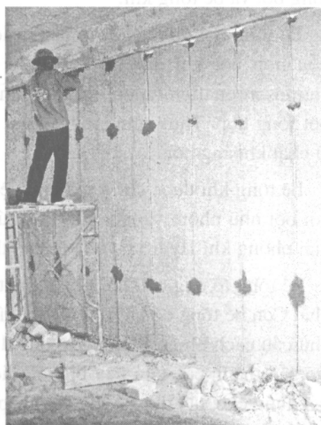
Hình 5.2. Sản phẩm Khối và tấm tường lắp nhanh từ bê tông Polystyrene [67]
