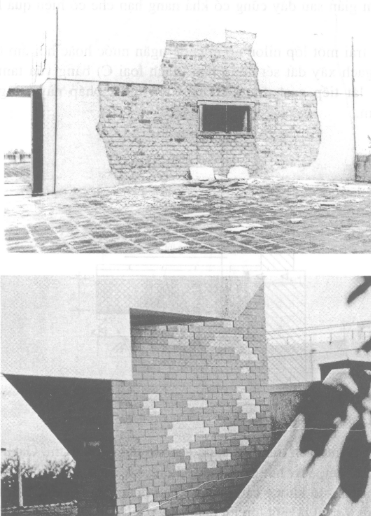
Hình 5.22. Bong rộp lớp trát đá rửa và gạch ốp trang trí ngoài tường
